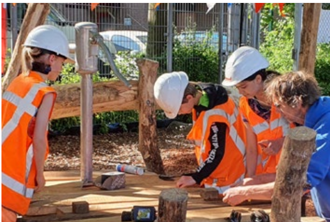
Laatste voorbereidingen waterput
