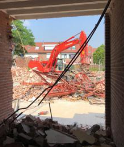
gebouw wordt gesloopt om een nieuwe indeling en om ruimte op het terrein te creëren voor de bestuur) en de gezamenlijke nieuwe sporthal.
